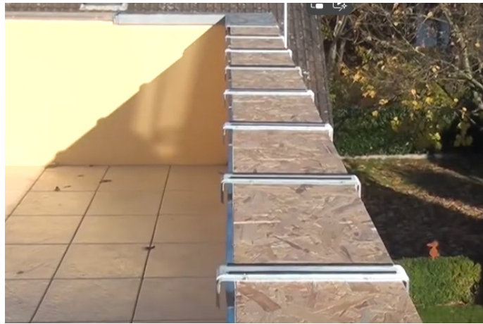
Typische Rillenhalter (Stoßverbinder). In die Rillen werden EPDM-Dichtungslippen eingeschoben. Quellen: ibh, You Tube Richard Brink GmbH
