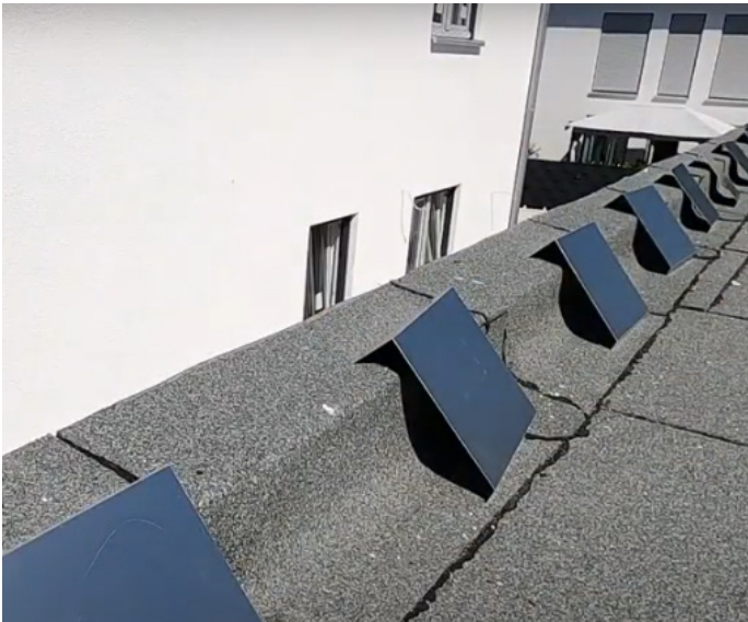
Gekantete Haltebleche, Unterbleche. Hier mit Impulsnagler angeschossen. Quelle: You Tube DACH PRO Mauerabdeckung aus RHEINZINK
