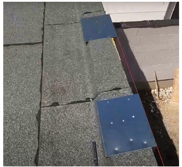
Gekantete Haltebleche, Unterbleche. Hier mit Impulsnagler angeschossen. Quelle: You Tube DACH PRO Mauerabdeckung aus RHEINZINK
